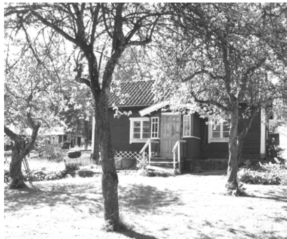
Torpet Abrahamsberg - idag med lummig grönska - är nu rivningshotat - kommunen vill bygga parhus på tomten.
