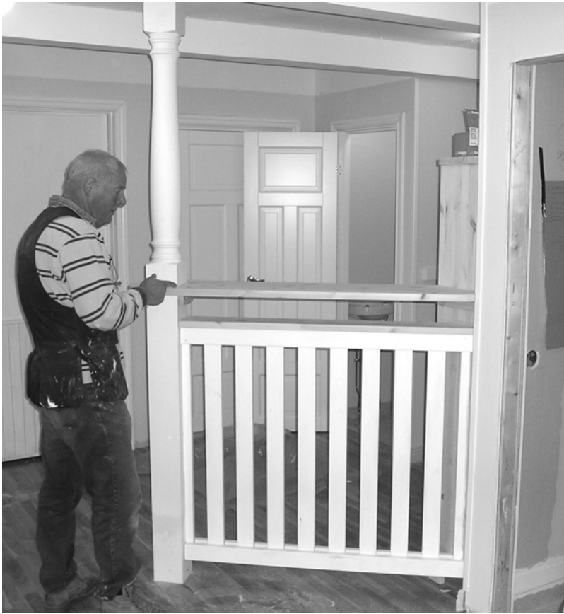
Här är Bygdegårdens entréhall ännu inte riktigt färdig. Roland Janson fixar med inredningen. (Foto: Gunnar Bergsten)
